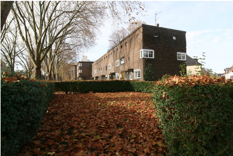
Dreigeschossige Reihenhäuser des Typs III aus Backstein mit Vorgartenbereich am Freiheitsring in Frechen (2021) Fotograf/Urheber: Nicole Schmitz
