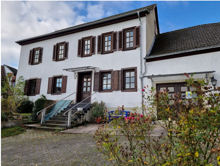
Ansicht der ehemaligen Schule, heute Gemeindezentrum in der Kirchgasse 4 in Laubenheim (2021) Fotograf/Urheber: Jochen Mohr
