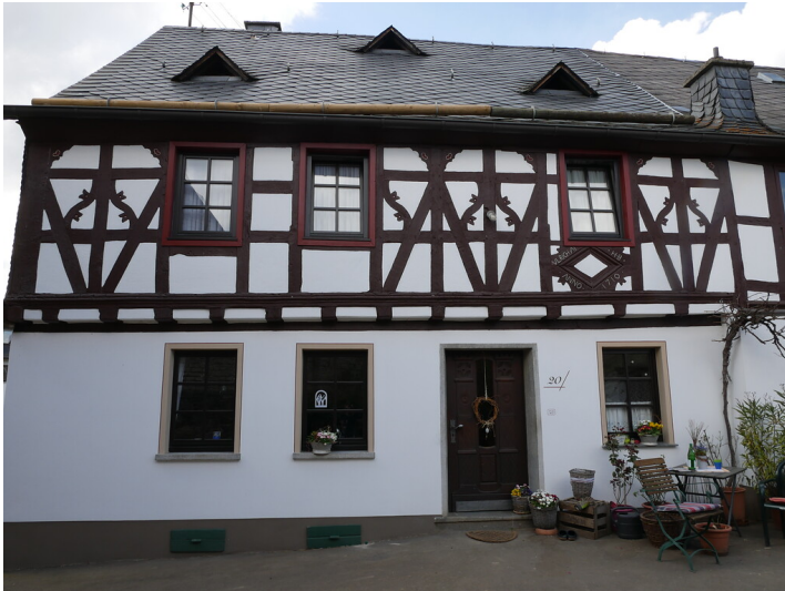
Das Fachwerkhaus "Haus Stienes" in der Ringstraße 20 in Hottenbach (2021) Fotograf/Urheber: Hans-Joachim Brusius
