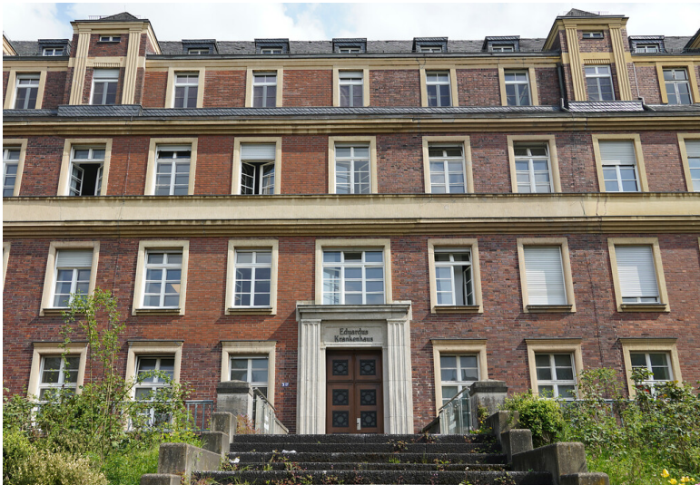
Haupteingang des Eduardus-Krankenhauses in Köln-Deutz (2022) Fotograf/Urheber: Ute Schumacher
