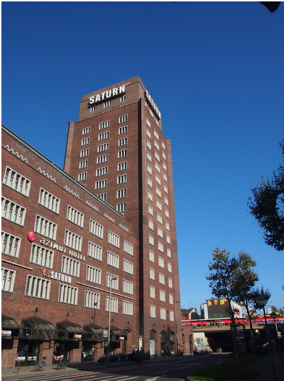
Das Hansahochhaus in Köln vom Hansaring aus gesehen (2021). Fotograf/Urheber: Julian Weller
