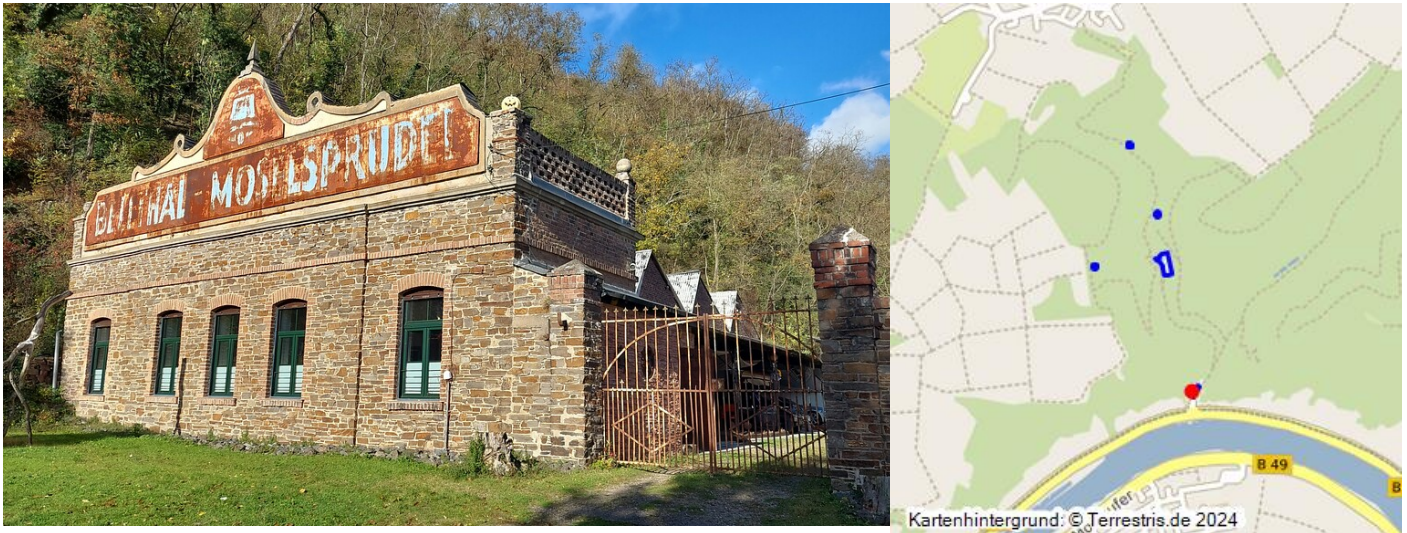
Ruine der Abfüllanlage der zwischen 1870 und 1975 betriebenen Firma "Bellthal Moselsprudel" bei Kobern-Gondorf (2021). Fotograf/Urheber: Franz-Josef Knöchel
