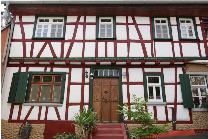
Die Fassade des Wohnhauses der Hofanlage Naheweinstraße 38 in Laubenheim (2021) Fotograf/Urheber: Stephanie Schepp
