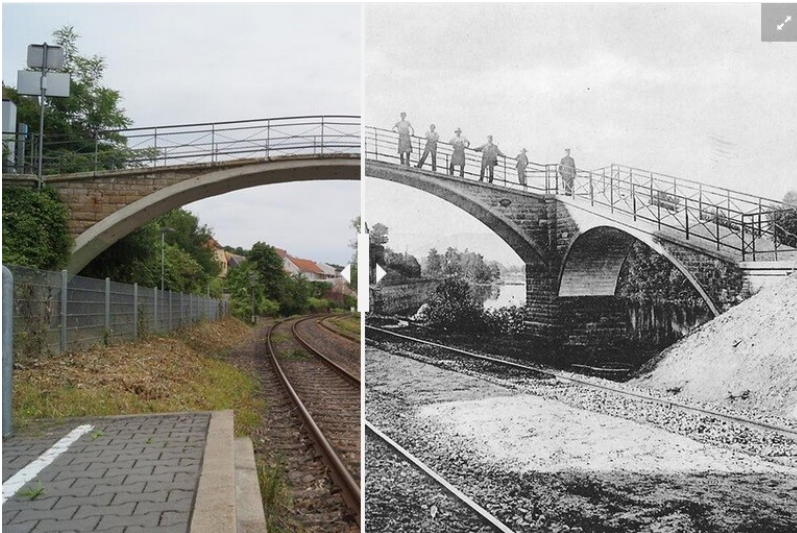
Die Laubenheimer Bogenbrücke im Wandel der Zeit (1900/2022) Fotograf/Urheber: unbekannt
