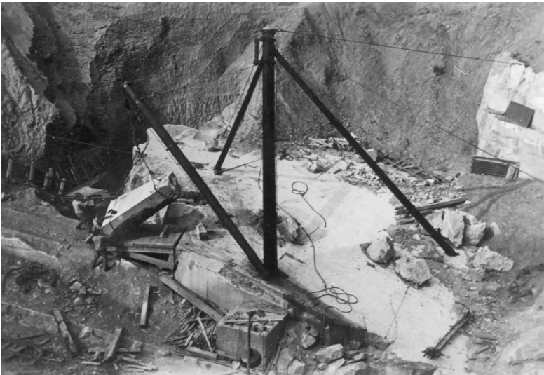
Historische Aufnahme der Bergung eines Blocks im Steinbruch Wirbelau Fotograf/Urheber: unbekannt
