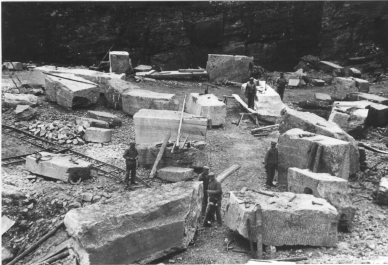
Historische Aufnahme eines Blocklagers im Steinbruch "Famosa S" in Schubach Fotograf/Urheber: unbekannt
