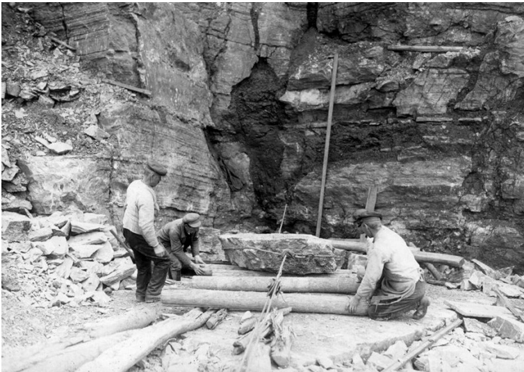
Historische Aufnahme der Arbeit im Wiedischen Steinbruch in Schupbach Fotograf/Urheber: unbekannt
