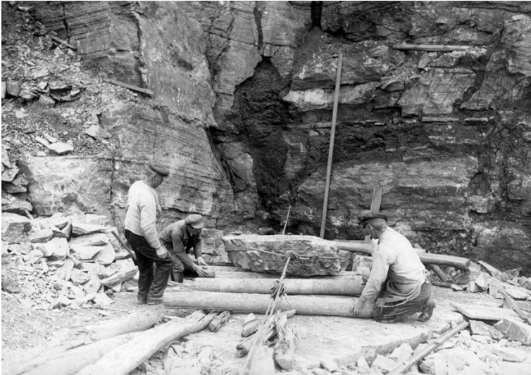
Historische Aufnahme der Arbeit im Wiedischen Steinbruch in Schubbach Fotograf/Urheber: unbekannt
