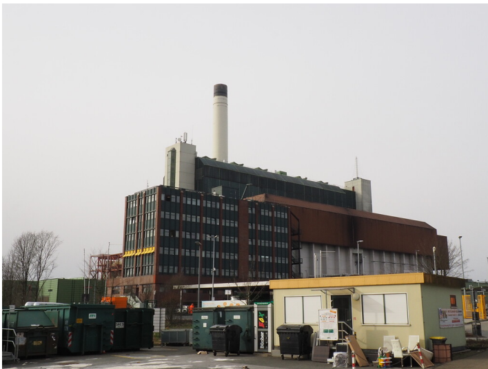
Steinbruch Küllenhahn - Blick von der Pforte auf das 1976 fertiggestellte Müllheizkraftwerk (2021) Fotograf/Urheber: Jörn Kling
