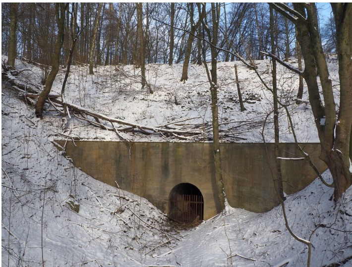
Mit einem Tunnelbauwerk versehene Einfahrt in den Bochumer Bruch (2021) Fotograf/Urheber: Jörn Kling
