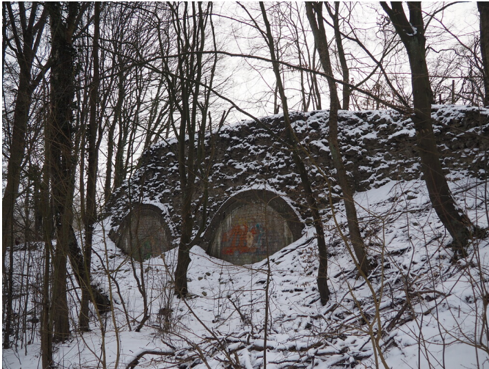
Ruine des Trichteralkofens Hammerstein (2021) Fotograf/Urheber: Jörn Kling
