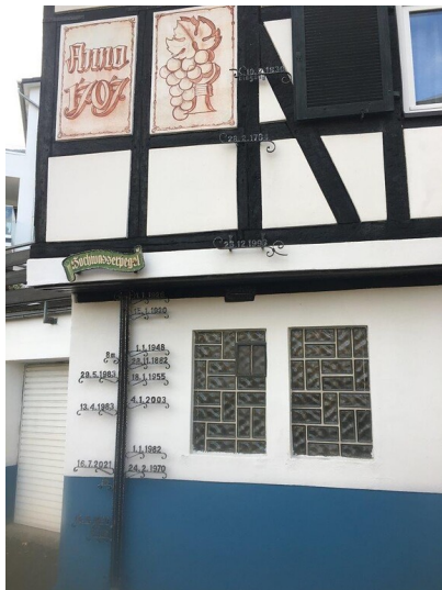
Hochwasserpegel Koblenz-Lay Fotograf/Urheber: Herdes, Hedwig
