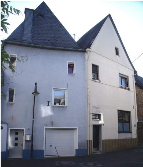
Kaufunger Straße 1 und 5 Koblenz-Lay (2017) Fotograf/Urheber: Richard Theisen
