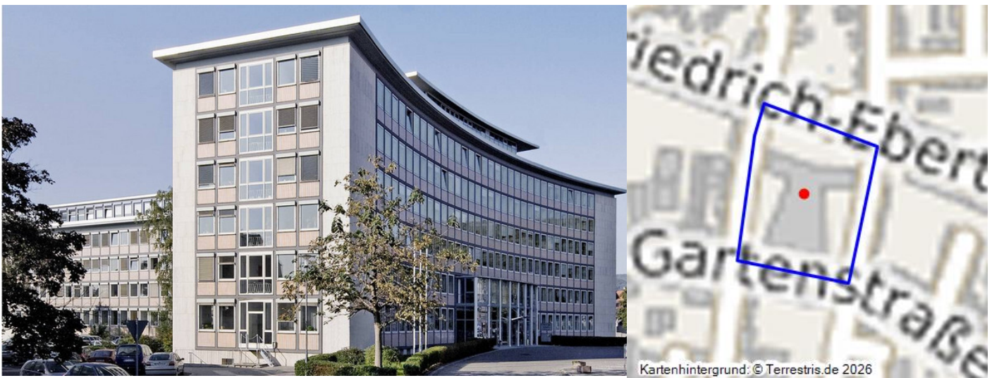
Verwaltungsgebäude Friedrich-Ebert-Straße 14 Neustadt Fotograf/Urheber: SGD Süd
