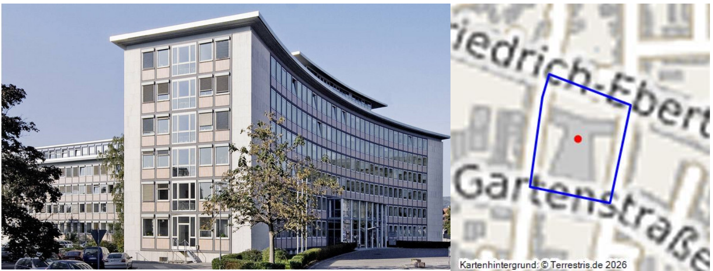
Verwaltungsgebäude Friedrich-Ebert-Straße 14 Neustadt Fotograf/Urheber: SGD Süd
