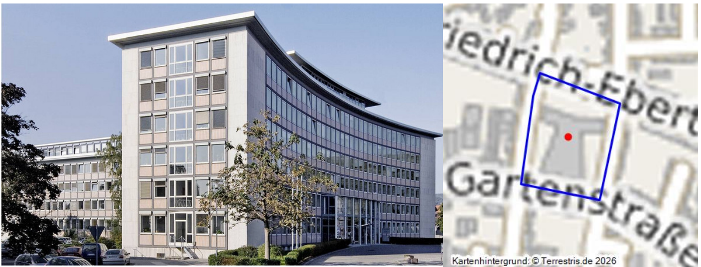
Verwaltungsgebäude Friedrich-Ebert-Straße 14 Neustadt Fotograf/Urheber: SGD Süd
