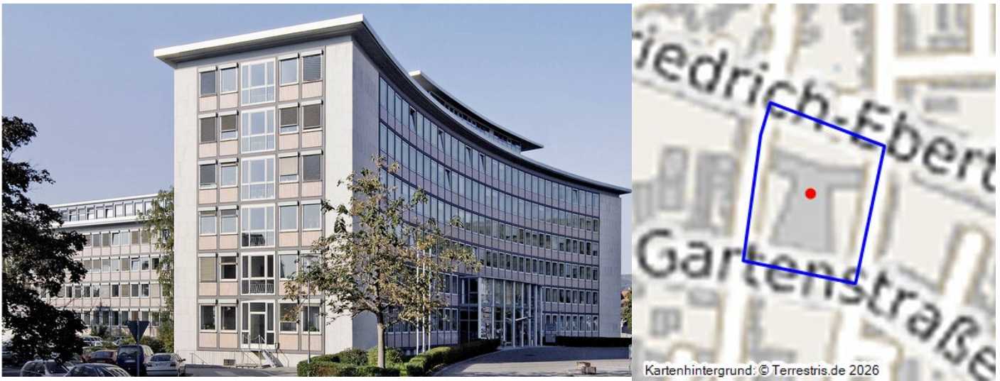
Verwaltungsgebäude Friedrich-Ebert-Straße 14 Neustadt Fotograf/Urheber: SGD Süd
