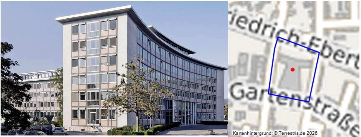
Verwaltungsgebäude Friedrich-Ebert-Straße 14 Neustadt Fotograf/Urheber: SGD Süd
