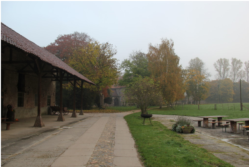
Das Klostergelände von Graefenthal mit der Remise, dem Klausurgebäude, der ehemaligen Klosterkirche sowie der Klostermauer im Hintergrund (2012). Fotograf/Urheber: Burggraaff, Peter
