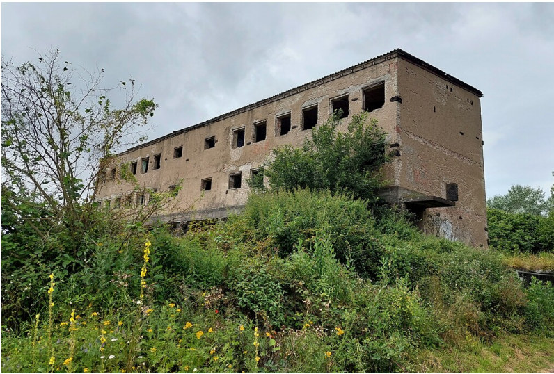
Die Ruine der früheren Heimschule am Laacher See bei Nickenich, Ansicht der Rückseite im Osten (2021). Fotograf/Urheber: Franz-Josef Knöchel
