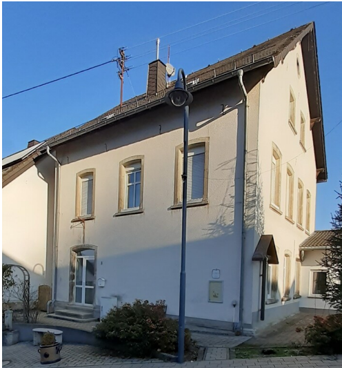
Altes Schulgebäude in Kammerforst, Hauptstraße 3 (2020). Fotograf/Urheber: Marianne Karthaus
