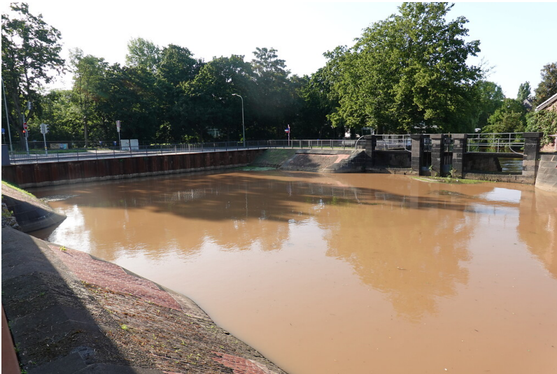
Epanchoir am Nordkanal in Neuss (2021) Fotograf/Urheber: Helmut Friedrichs
