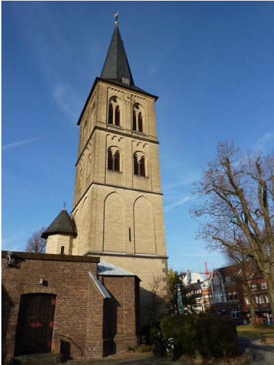
Kirchturm von St. Michael in Dormagen (2011) Fotograf/Urheber: Chris06
