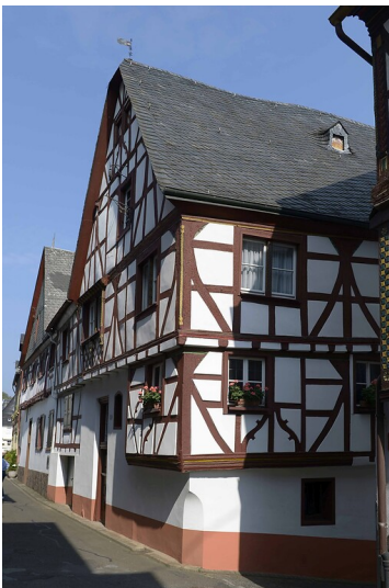
Fachwerk-Wohnhaus Christophorusstraße Sankt Aldegund (2017). Fotograf/Urheber: Markus Kroth
