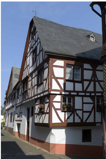
Fachwerk-Wohnhaus Christophorusstraße Sankt Aldegund (2017). Fotograf/Urheber: Markus Kroth
