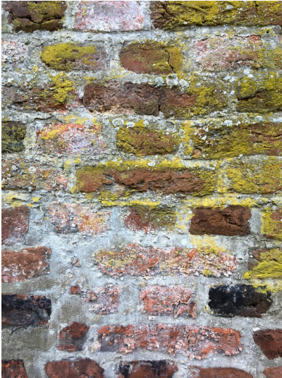
Nahaufnahme der Mauer am Schloss Liedberg (2018) Fotograf/Urheber: Martin Sorg
