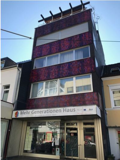
Wohn- und Geschäftshaus mit rot-blauer KerAion-Fassade in Frechen (2020) Fotograf/Urheber: Nicole Schmitz
