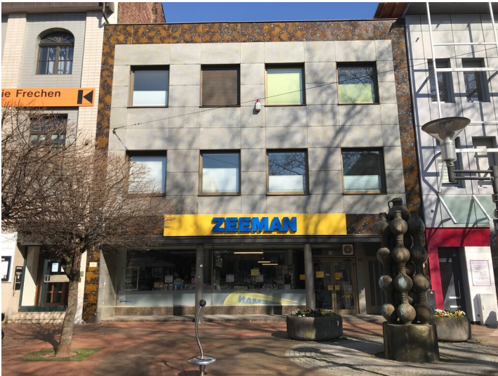
Wohn- und Geschäftshaus mit Fassadenverzierung aus braunen KerAion-Platten in Frechen (2020) Fotograf/Urheber: Nicole Schmitz
