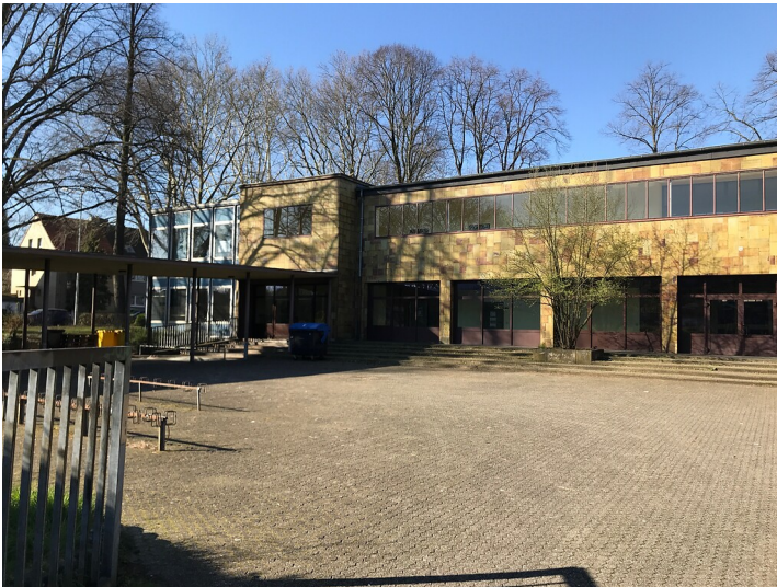
Die Fassade des ältesten Bauabschnittes der Lindenschule (heute Realschule) ist mit gelben Steinzeugplatten verkleidet (2020) Fotograf/Urheber: Nicole Schmitz
