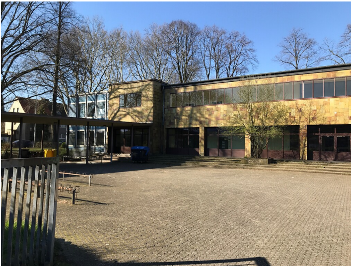
Die Fassade des ältesten Bauabschnittes der Lindenschule (heute Realschule) ist mit gelben Steinzeugplatten verkleidet (2020) Fotograf/Urheber: Nicole Schmitz
