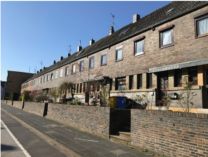
Die Fassaden der Reihenhäuser Typ I in der Keimesstraße in Frechen sind im Erdgeschoss mit Steinzeugplatten verziert (2020) Fotograf/Urheber: Nicole Schmitz
