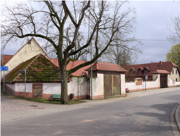
Blick auf den Dreiseithof Hauptstraße 17 in Weitersweiler von der Hauptstraße aus (2020) Fotograf/Urheber: Jürgen Cronauer
