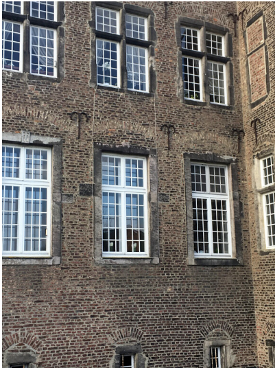
Mauern von Schloss Myllendonk (2018) Fotograf/Urheber: Martin Sorg
