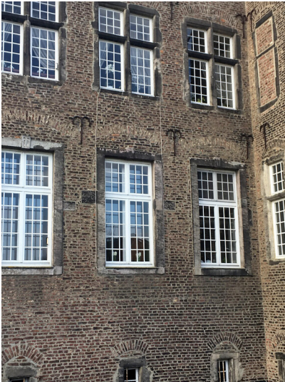
Mauern von Schloss Myllendonk (2018) Fotograf/Urheber: Martin Sorg
