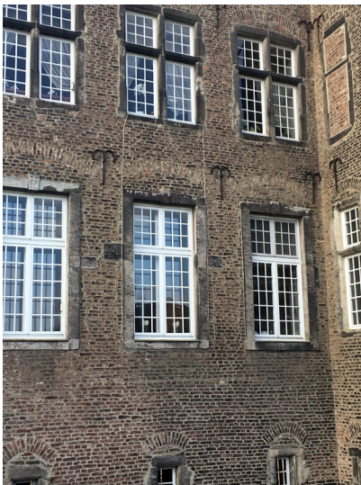
Mauern von Schloss Myllendonk (2018) Fotograf/Urheber: Martin Sorg
