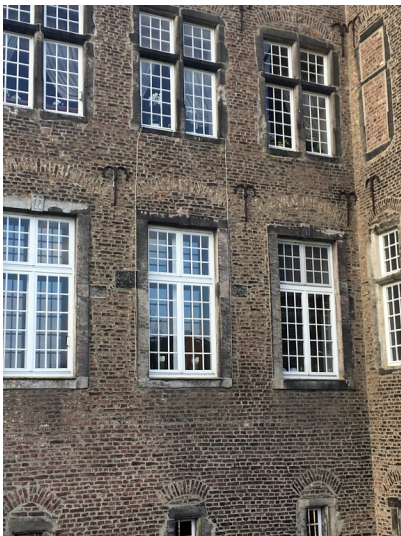
Mauern von Schloss Myllendonk (2018) Fotograf/Urheber: Martin Sorg
