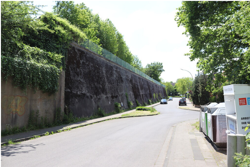
Nördliche Grenze des Bergwerksgelände der Gewerkschaft Carolus Magnus. Links ist der Brückenansatz für die Werksbahn erkennbar (2021). Fotograf/Urheber: Robert Gansen
