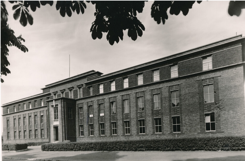
Verwaltungs- und Betriebsgebäude der Gewerkschaft Carolus Magnus in Palenberg (historische Aufnahme) Fotograf/Urheber: unbekannt
