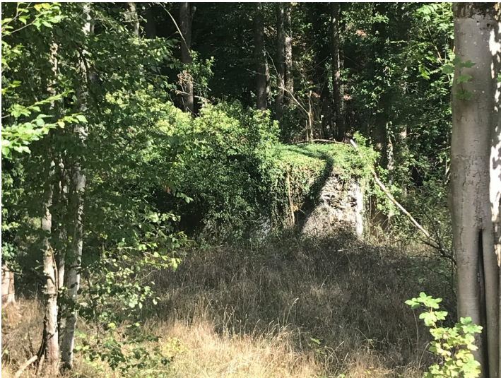
Wasserwerk Schmidt - Vossenack (2022) Fotograf/Urheber: Nicole Schmitz
