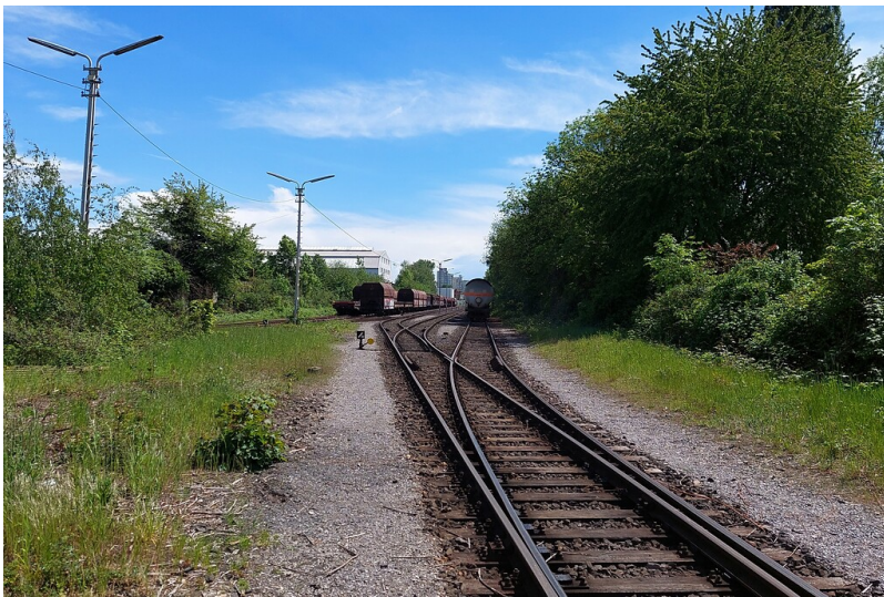
Blick vom Lokschuppen an der Kölner Südbrücke über die Gleise der Hafenbahn in Richtung des Verschiebe- bzw. Sammelbahnhofs Köln-Poll (2021). Fotograf/Urheber: Franz-Josef Knöchel
