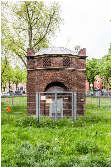
Transformatorenhäuschen in Köln-Sülz (2021) Fotograf/Urheber: Sebastian Löder
