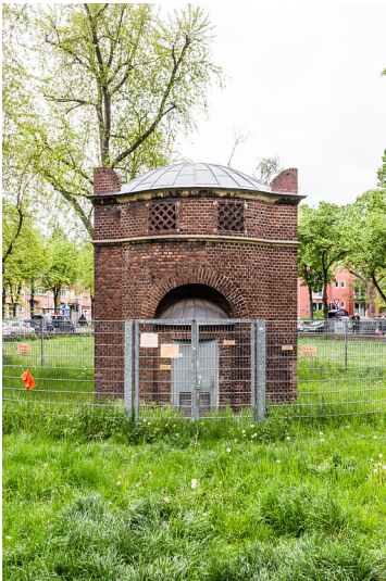
Transformatorenhäuschen in Köln-Sülz (2021) Fotograf/Urheber: Sebastian Löder
