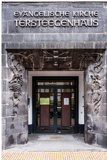
Haupteingang der Evangelischen Kirche Tersteegenhaus in Köln-Sülz (2021) Fotograf/Urheber: Sebastian Löder
