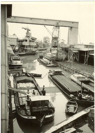
Breitenburger Schiffahrtskanal - Südlicher Fabrikhafen der Breitenburger-Portland-Cement-Fabrik, Sackverladung (1953) Fotograf/Urheber: unbekannt
