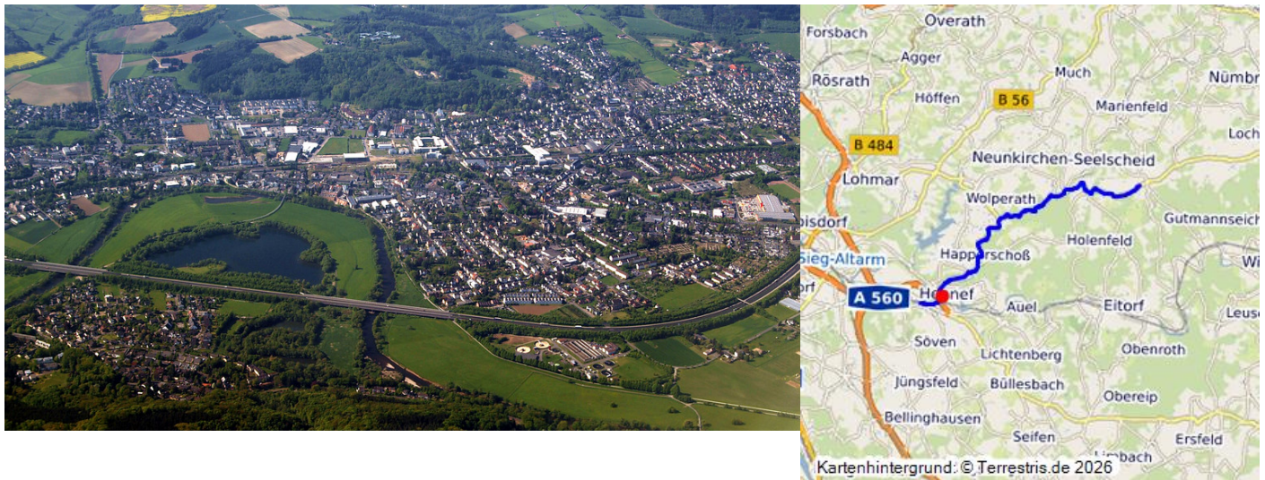
Luftbild mit Blick in südwestliche Richtung auf Hennef (2008), im Vordergrund die Bundesautobahn A 560 und die Sieg, die den Allner See links im Bild einrahmen. Fotograf/Urheber: Toksave
