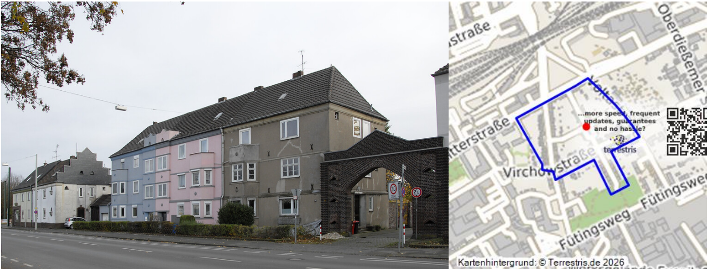
Siedlung Ritterfeld - Ansicht Ritterstraße (2020) Fotograf/Urheber: Stephan Strauß
