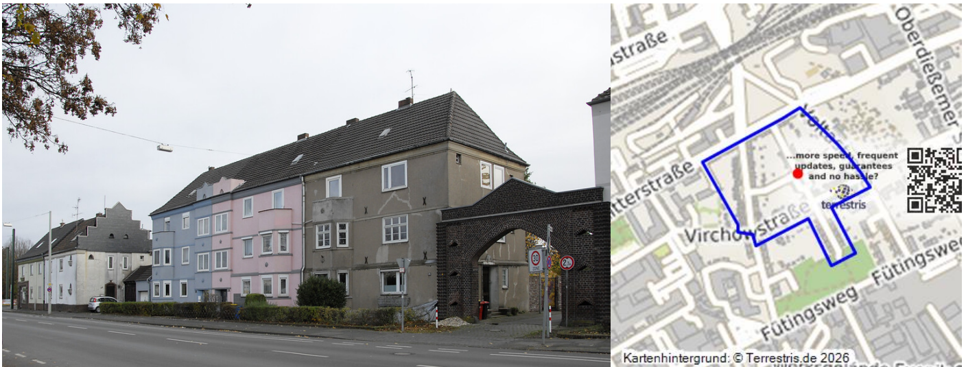
Siedlung Ritterfeld - Ansicht Ritterstraße (2020) Fotograf/Urheber: Stephan Strauß
