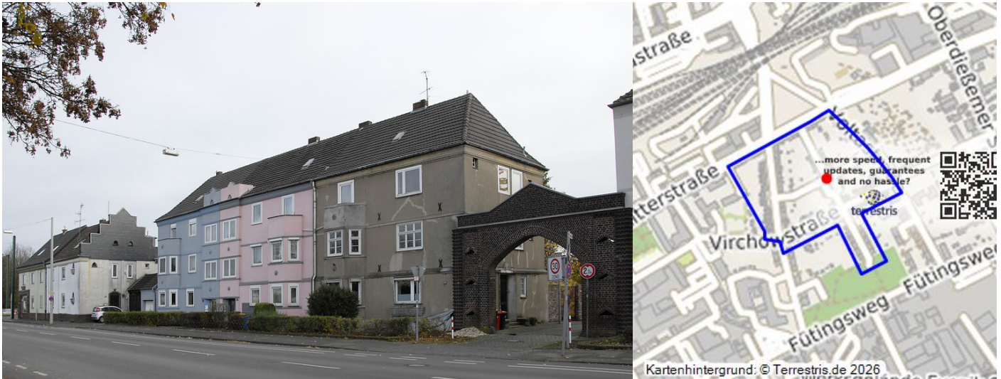
Siedlung Ritterfeld - Ansicht Ritterstraße (2020) Fotograf/Urheber: Stephan Strauß
