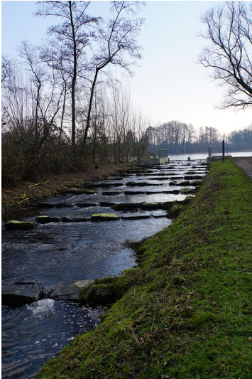
Mit der Fischaufstiegsanlage am Ferkensbruch stellte der Netteverband die Durchgängigkeit der Nette für Wasserlebewesen wieder her. (2018) Fotograf/Urheber: Nicole Schmitz
