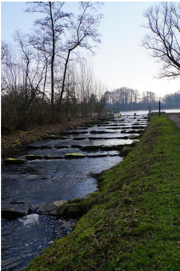
Mit der Fischaufstiegsanlage am Ferkenbruch stellte der Netteverband die Durchgängigkeit der Nette für Wasserlebewesen wieder her. (2018) Fotograf/Urheber: Nicole Schmitz
