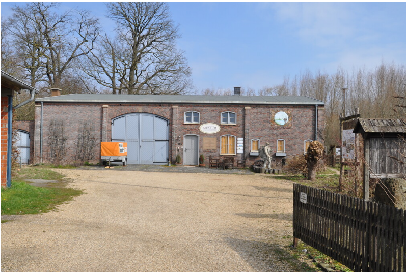
Gebäude des Landschaftshofes Baerlo (2021) Fotograf/Urheber: Nicole Schmitz
