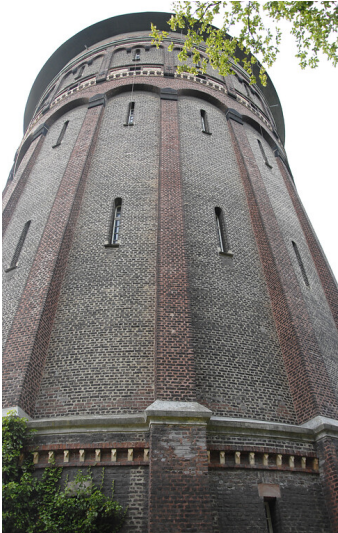
Wasserturm Kempener Feld (2020) Fotograf/Urheber: Stephan Strauß
