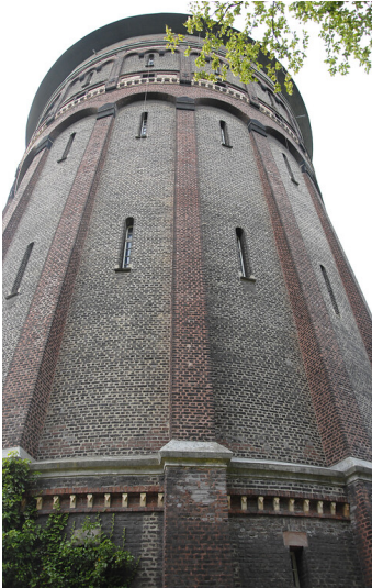
Wasserturm Kempener Feld (2020) Fotograf/Urheber: Stephan Strauß
