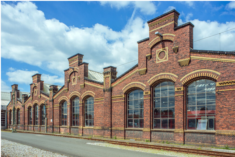
Eisenbahn-Ausbesserungswerk Oppum (2017) Fotograf/Urheber: Jürgen Gregori
